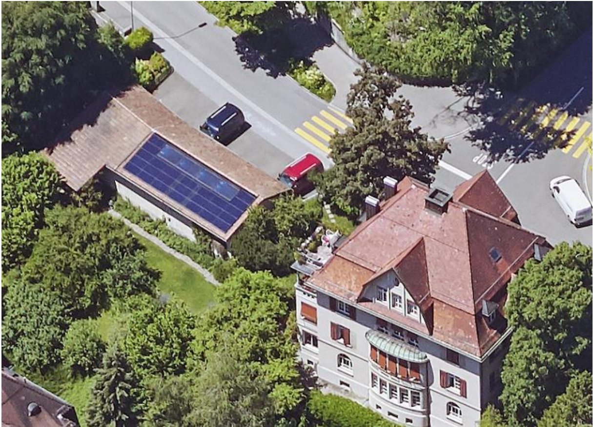
Abbildung 15: Die Indachanlage auf dem Nebengebäude mit schwach geneigtem Dach entlastet das Dach des Hauptgebäudes (Foto: Stadtplan / Schrägluftbild 2024).
