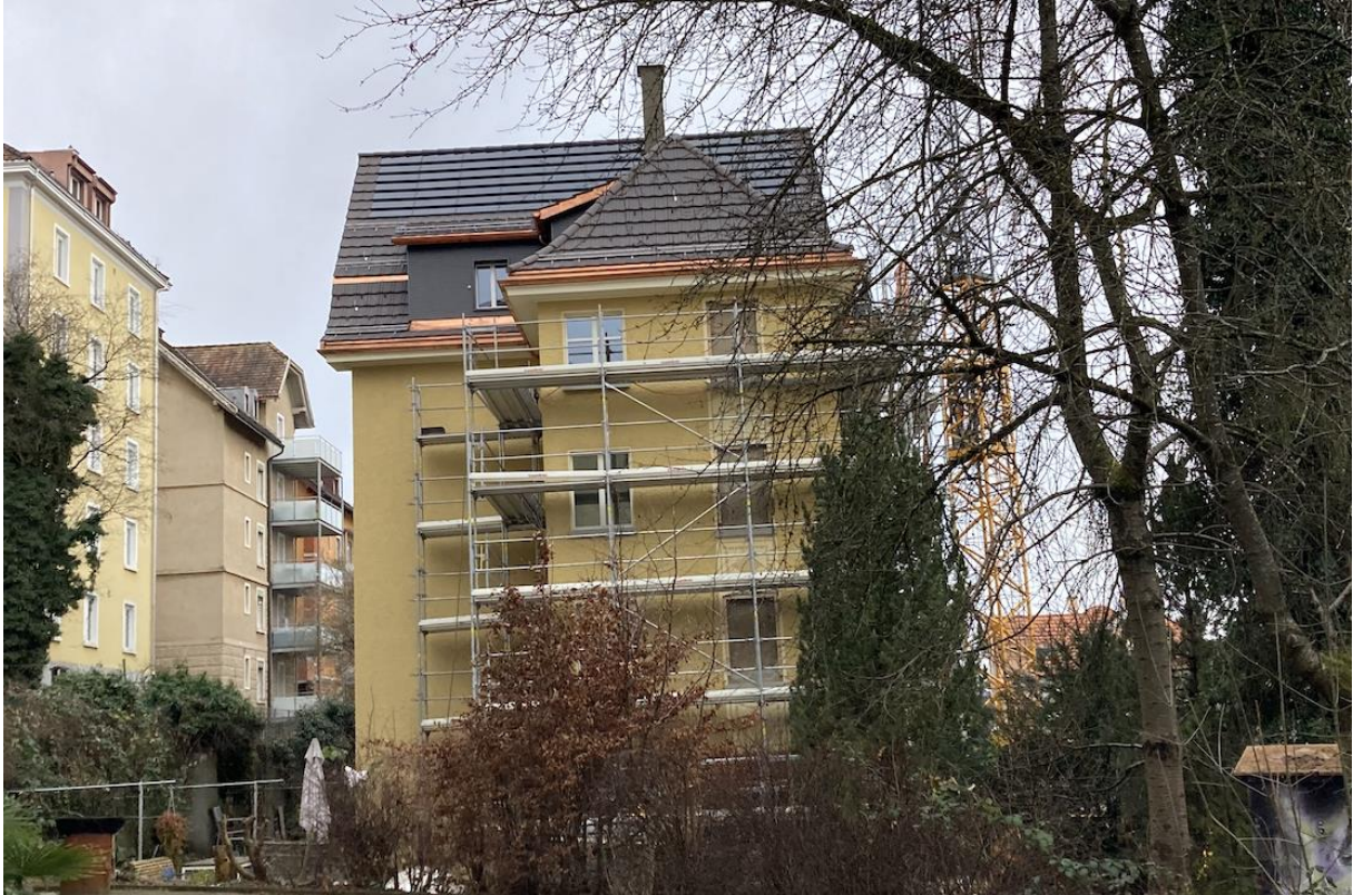
Abbildung 48: Kleinformatige, horizontalbetonte Verlegung wie ein Tonziegeldach mit nahtlosem Ineinandergreifen von Modulen und Ziegeln. Die dunkle Modulfarbe passt sich der dunkelbraunen Tonziegelfarbe an. Ansicht der Nordostfassade (Foto: Büro für Baugeschichte, 2024).
