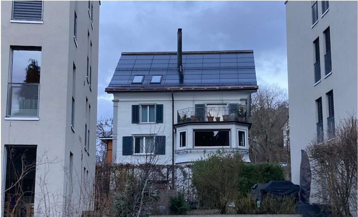
Abbildung 42: Die vollflächige Indachanlage mit dunklen Modulen wirkt einheitlich und berücksichtigt Dachdurchbrüche wie Kamin und Dachflächenfenster auf der Westseite und Quergiebelanbau auf der Ostseite (Foto: Büro für Baugeschichte, 2024).
