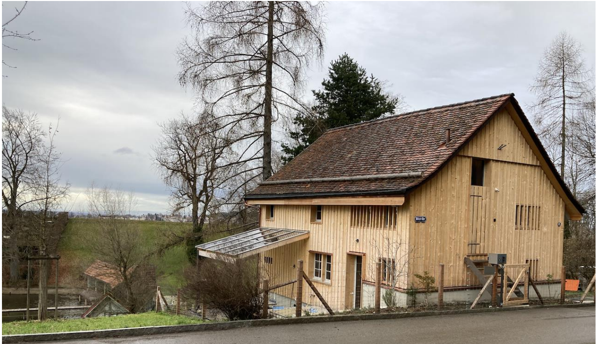
Abbildung 45: Solaranlage auf angebautem traufseitigem Pultdach als Sitzplatzüberdachung (Pergola) mit grosser Lichtdurchlässigkeit und gleichzeitigem Sonnenschutz. Die Lage auf dem Anbau entlastet das Hauptdach mit historischen Biberschwanzziegeln (Foto: Büro für Baugeschichte, 2024).
