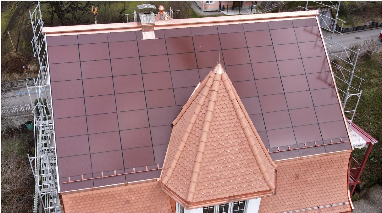
Abbildung 39: Die braune Modulfarbe passt sich der natürlichen Tonziegelfarbe an. Die vollflächige Anordnung im oberen Bereich des Mansarddachs trägt zu einem ruhigen Erscheinungsbild bei. Mit Blindmodulen kann gut auf die Dachdurchbrüche reagiert werden (Foto: Drohnenaufnahme, Denkmalpflege Stadt St.Gallen / Julian Zahner, 2024).
