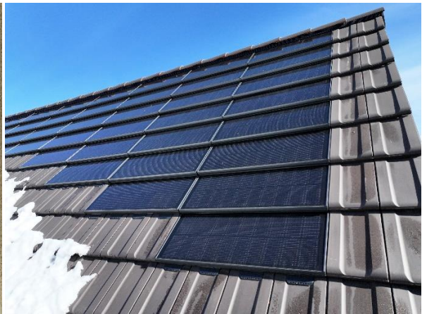
Abbildung 50: Detailansicht der Kombination von Dachziegeln und Solarmodulen (Foto: Zürcher Ziegeleien AG, 2025).
