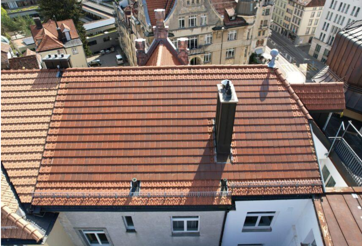
Abbildung 51: Das Kleinformat der Solarziegel nimmt die horizontale Verlegungsart von herkömmlichen Ziegeldächern auf (Foto: Jacobi-Walther Dachziegel, 2024).
