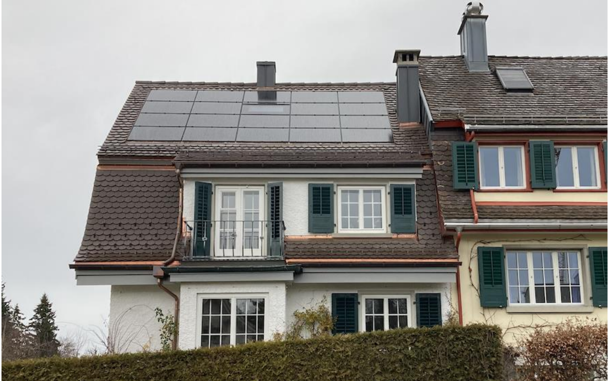
Abbildung 36: Die dunkle Modulfarbe passt sich der dunkelbraunen Tonziegelfarbe an. Die flächige Anordnung im oberen Bereich des Mansarddaches inklusive Dachflächenfenster berücksichtigt Dachdurchbrüche und Dachränder (Foto: Büro für Baugeschichte, 2024).
