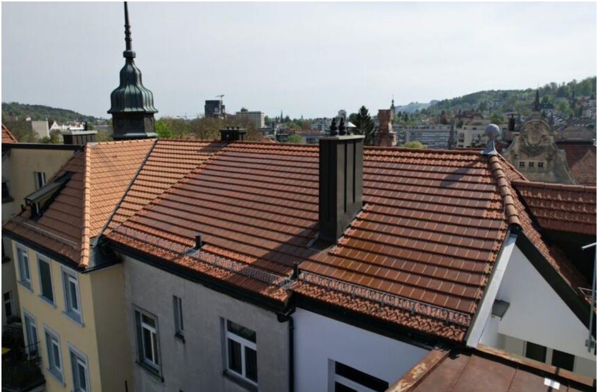
Abbildung 9: Terrakottafarbene Solarziegel in Kombination mit bestehenden Herzziegeln. Die charakteristische Struktur und das Erscheinungsbild der historischen Dachlandschaft können dadurch erhalten werden (Foto: Jacobi-Walther, 2024).
