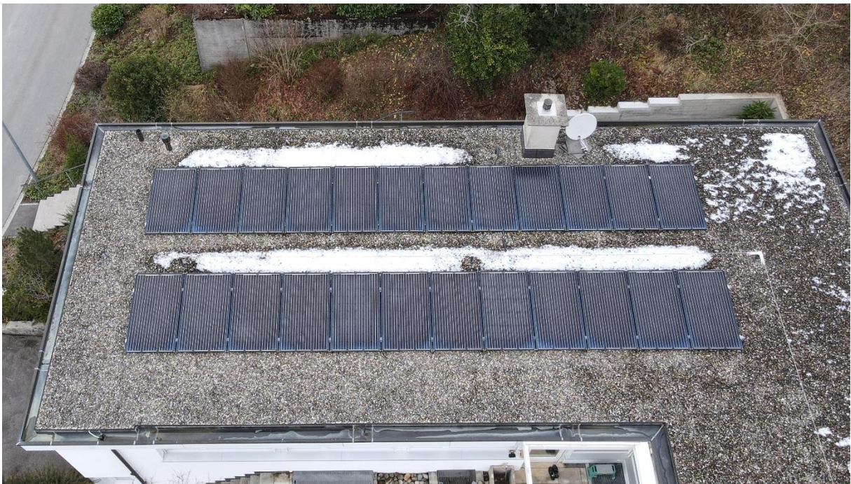
Abbildung 10: Flach aufgelegte Photovoltaikmodule in zwei regelmässigen Reihen auf einem Flachdach: nimmt Rücksicht auf die Architektur, tritt von ausserhalb der Siedlung kaum in Erscheinung und ermöglicht weiterhin den praktisch ungestörten Blick über die Dächer innerhalb der Teppichsiedlung (Foto: Denkmalpflege Stadt St.Gallen / Julian Zahner, 2024).
