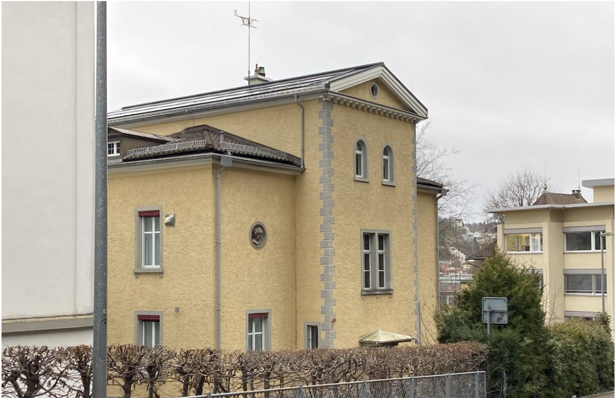
Abbildung 33: Die dunkle Modulfarbe passt sich der dunkelbraunen Tonziegelfarbe an. Die flächige Anordnung auf beiden Seiten des schwach geneigten Dachs ist kaum einsehbar; die Verlegung berücksichtigt Dachdurchbrüche und Dachränder (Foto: Büro für Baugeschichte, 2024).
