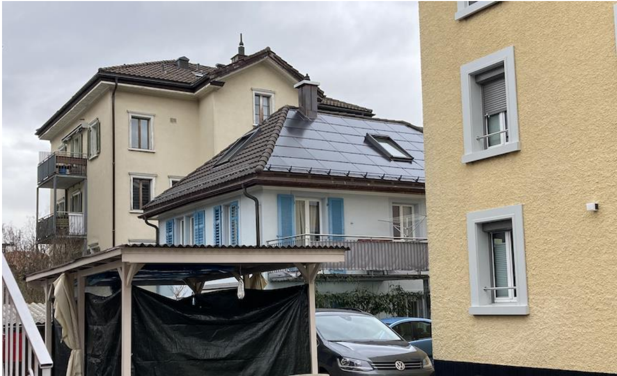
Abbildung 27: Die dunkle Modulfarbe nimmt die dunkelbraune Tonziegelfarbe auf. Die flächige Anordnung auf der Südostseite des Walmdaches berücksichtigt Dachdurchbrüche und passt sich an die Walmdachgrat- und Firstziegel an (Foto: Büro für Baugeschichte, 2024).
