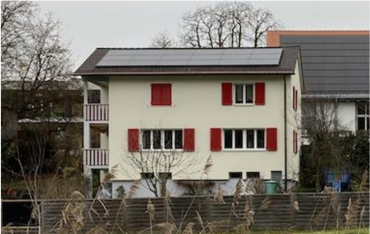
Abbildung 12: Die dunkle Modulfarbe passt sich der dunkelbraunen Tonziegelfarbe an. Die rechteckig zusammenhängende Anlage lässt einen Dachrand auf allen Seiten frei und fällt dadurch von den Giebelseiten nicht negativ in Erscheinung. Blick von Südosten (Foto: Büro für Baugeschichte 2024).
