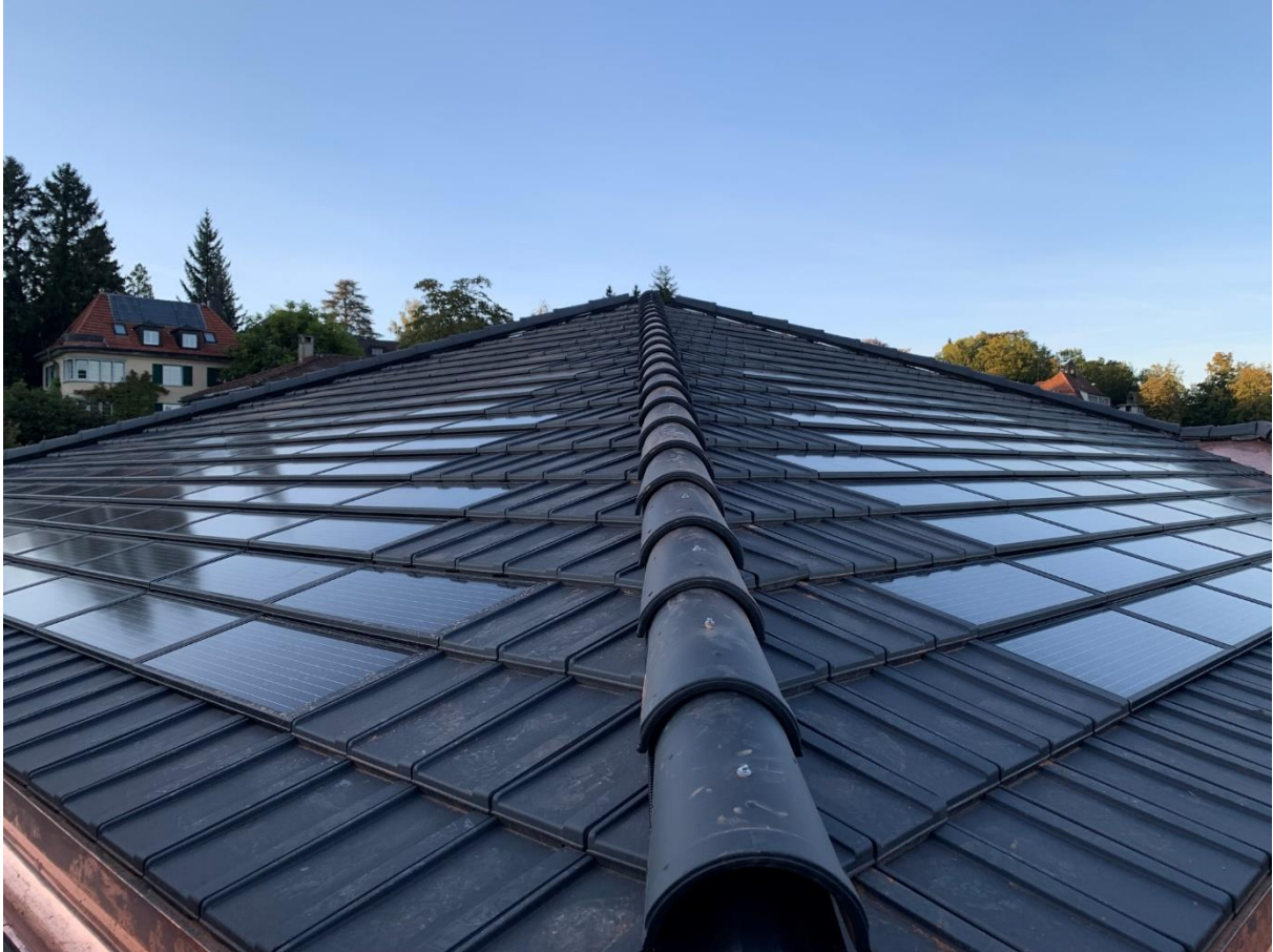
Abbildung 5: Solarmodule, die in Höhe und Versatz die Ziegeleindeckung nachahmen und mit herkömmlichen Ziegeln kombinierbar sind, ermöglichen hier eine optimale Integration der Solaranlage in die Dachlandschaft (Foto: Privat, 2021).
