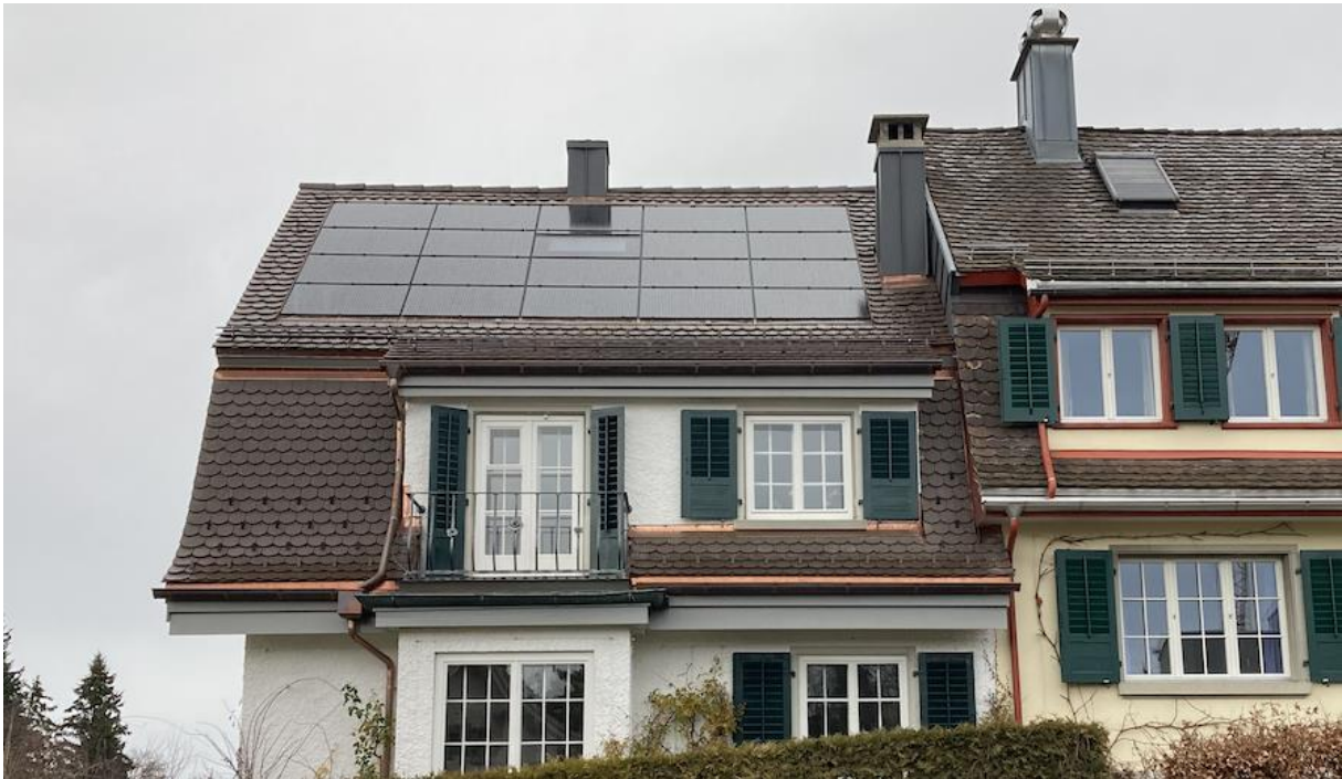
Abbildung 4: Indachanlage mit integriertem Dachfenster. Die Anlage beschränkt sich auf den oberen Teil des Mansarddaches, das rechteckige Feld mit ausreichend Abstand zu den Dachrändern ergibt ein ruhiges Erscheinungsbild (Foto: Büro für Baugeschichte, 2024).
