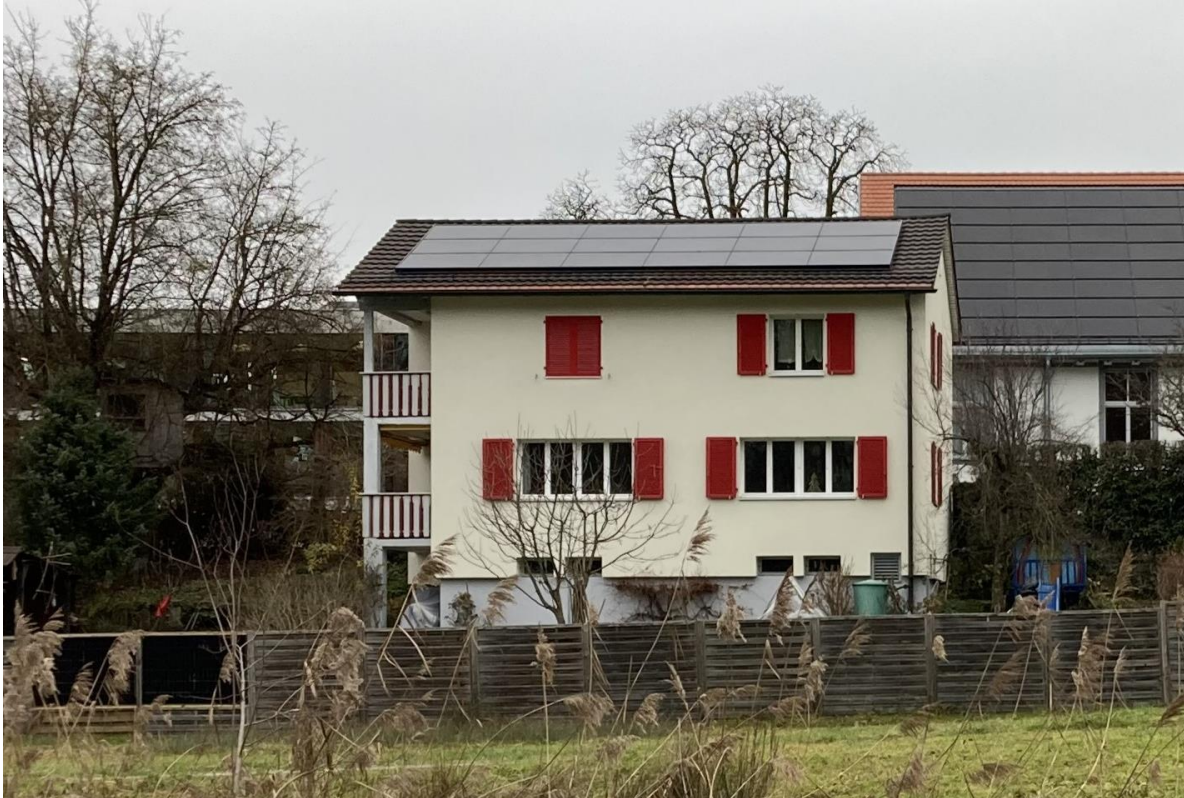
Abbildung 6: Aufdachanlage in rechteckiger Form, die einfachste Art einer Solaranlage, hier auch mit grosszügigem Abstand zu den Dachrändern (Foto: Büro für Baugeschichte, 2024).
