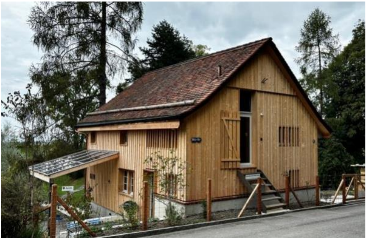
Abbildung 8: Entlastung des Hauptdachs mit historischen Ziegeln; Solaranlage auf angebautem traufseitigem Pultdach als Sitzplatzüberdachung in einfacher Konstruktion, Lichtdurchlässigkeit und Sonnenschutz in einem. Die transparenten Module inkl. Metallstege erinnern an Glasvordächer des 19. Jh. (Foto: Niklaus Bucher, 2024).
