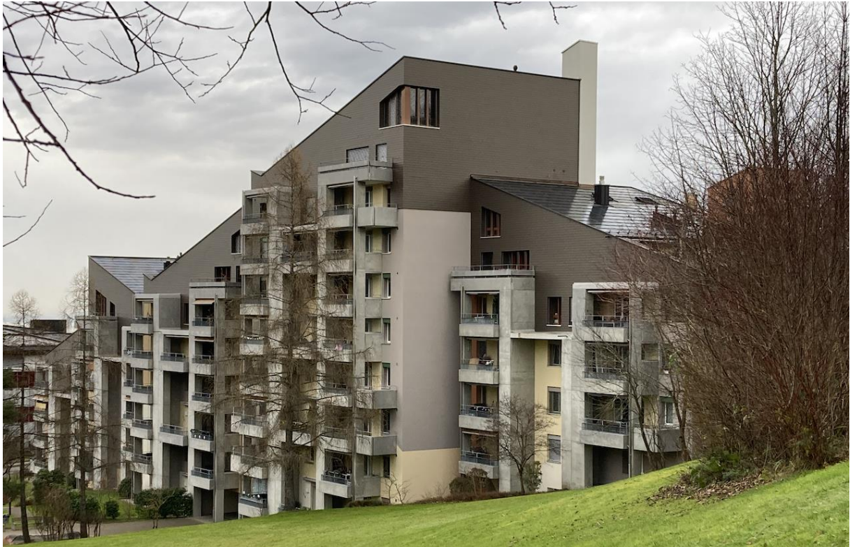
Abbildung 18: Die vollflächige Montage in den nach Süden bzw. Norden ausgerichteten Dachflächen wird Teil der architektonischen Ausformung mit Einbindung von Kamin und Dachflächenfenstern. Die schwarzen Module nehmen Bezug auf die vorhandenen dunklen Eternitdächer (Foto: Büro für Baugeschichte, 2024).
