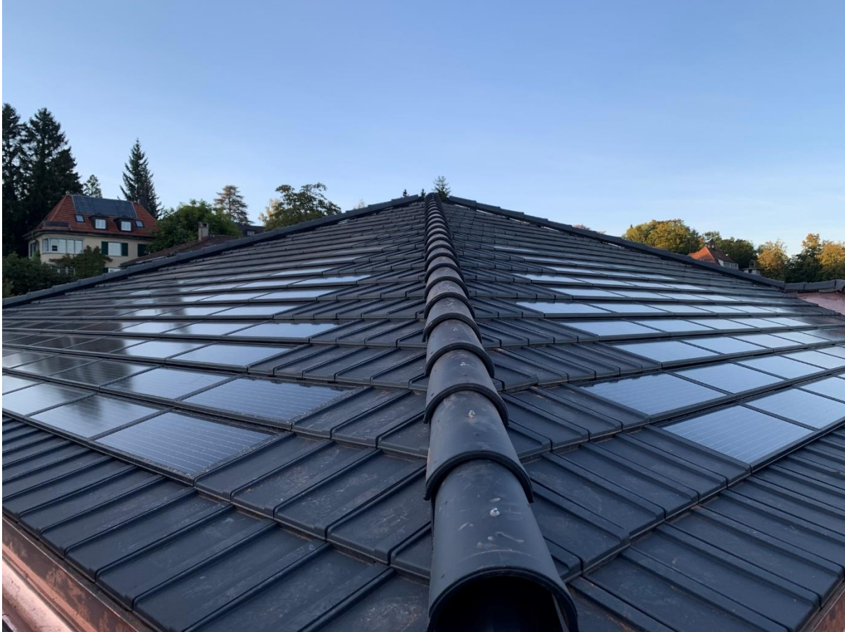
Abbildung 30: Kleinteilige, horizontalbetonte Verlegung, analog zu einem Tonziegeldach mit nahtlosem Ineinandergreifen von Modulen und Ziegeln. Die dunkle Modulfarbe passt sich der dunkelbraunen Tonziegelfarbe an. Ansicht auf Nordwest- und Südwestfassade (mit Photovoltaikanlage) (Foto: Privat, 2021).
