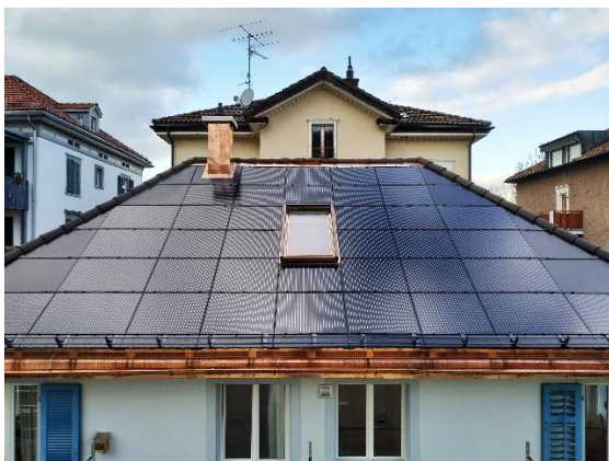
Abbildung 28: Vollflächige Anlage auf Südostseite mit Blindmodulen, First- und Gratziegeln und eingepasstem Dachflächenfenster (Foto: Privat, 2020).
