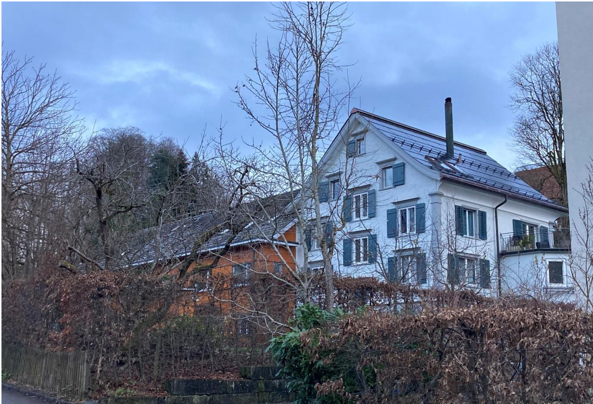
Abbildung 3: Vollflächige Indachanlage mit Blindmodulen und sorgfältig gestaltetem Dachrand (Foto: Denkmalpflege Stadt St.Gallen, 2023).
